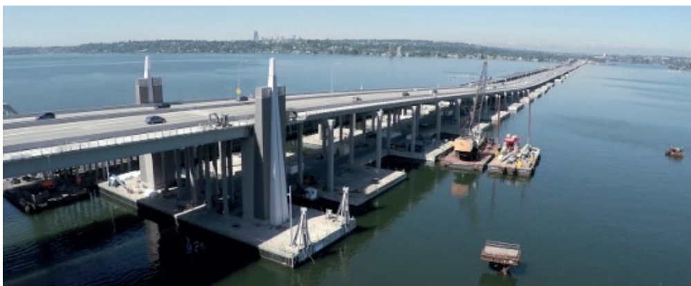
FIGUR 5. Eksempel på flydebro. Kilde: Washington State Department of Transportation.
