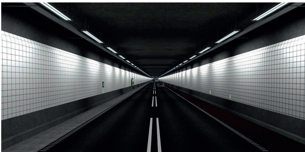
FIGUR 6. Eksempel på sænketunnel. Kilde: COWI.
