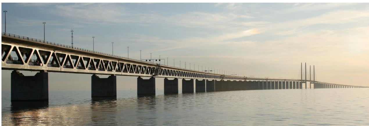
Figur 2. Øresundsbroen er et eksempel på en skråstagsbro, som er den brotype, der i dette notat forudsættes anlagt ved Als-Fyn Forbindelsen. Kilde: Paul Bischoff, GNU Free Documentation License, Version 1.2.
