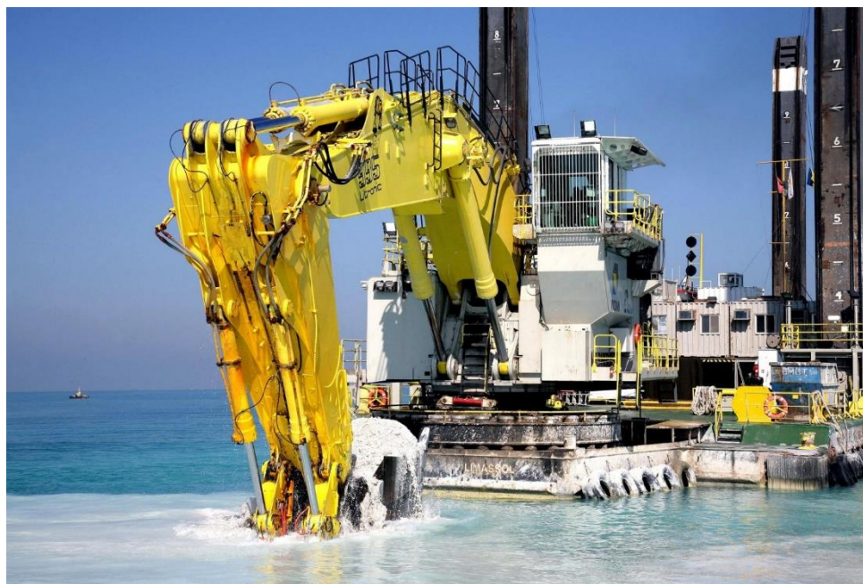
Figur 2 Gravemaskine monteret på pram
